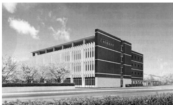
平成29年竣工予定
