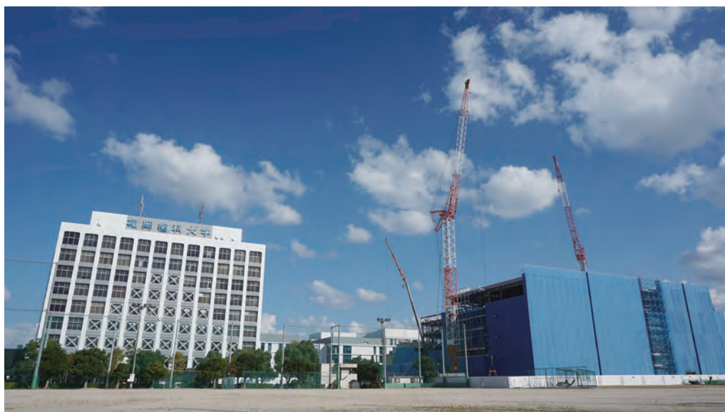
運動場側から撮影した校舎と建設中の新校舎
